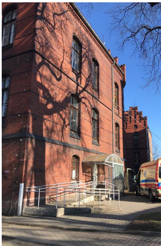
Zdj.5. Na parterze-wejście do aktualnej przychodni, która jest w zakresie remontu. Na II piętrze-przebudowywana Endokrynologia.
